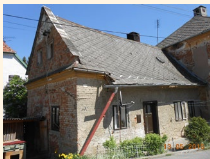
Budova č. p. 65, 13. 5. 2015
